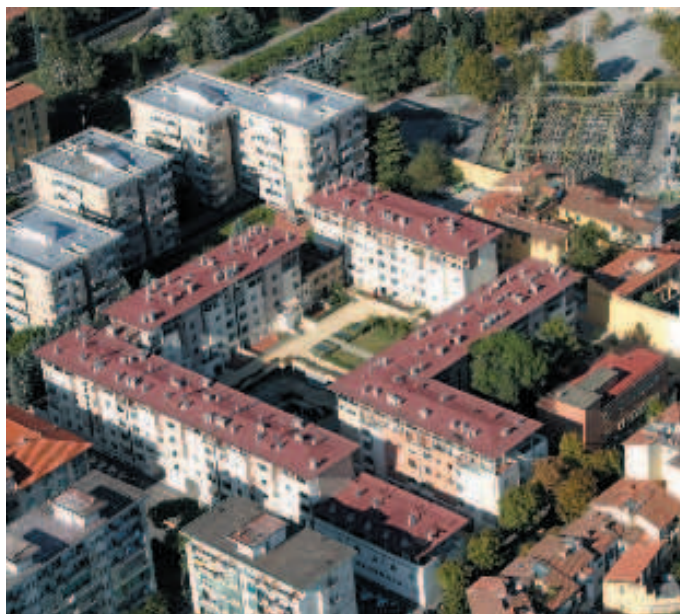
Uno dei cantieri oggetto dell'indagine della Procura
